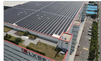
태양광 발전 시설 설치 모습
