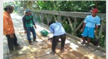
부미에담 마을 목조 교량 보수
