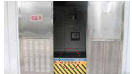
설치류(쥐) 출입 방지를 위한 방호턱 설치
