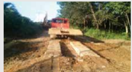
마을 도로 보수
