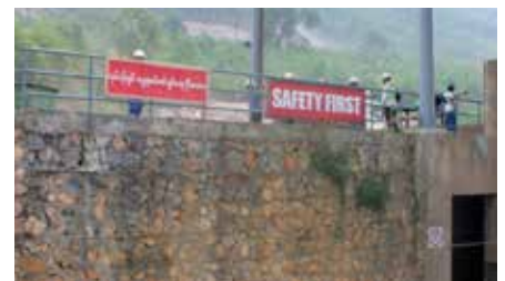
추락 방지 펜스 설치
