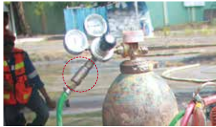
가스통 체인고정 및 역화방지장치 설치
