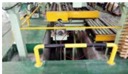
개구부* 입구 안전 난간 설치
