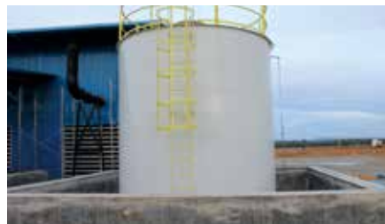
경유탱크 주변 누출방지턱 설치
