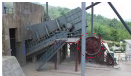
회전체 방호울 설치
